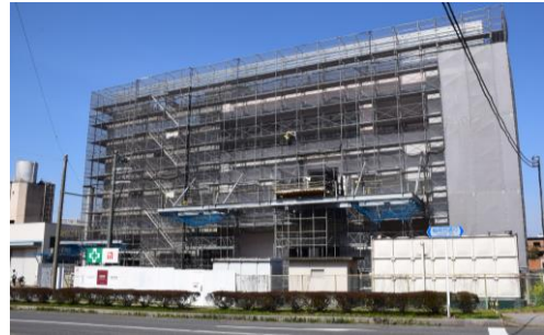
最も大きい予算63億円を投じる給食調理場 建設は鹿島建設（4月1日撮影）
