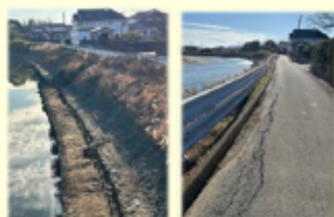
権現堂町会地域の 養老川護岸と側道の状況
