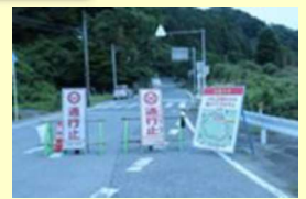
土砂災害による通行止め (6月国本地先)
